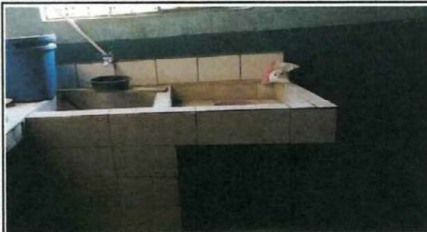
Foto 14: Sustrucción de pila de cemento de un lavadero, por una pila de cemento de dos lavaderos
