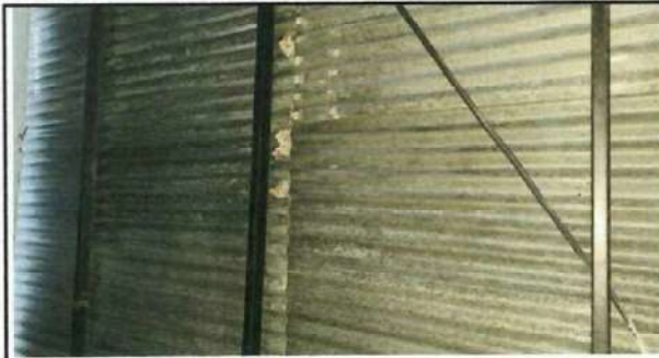
Foto 2: Sustitución de lámina por lámina troquelada, Aula 2
