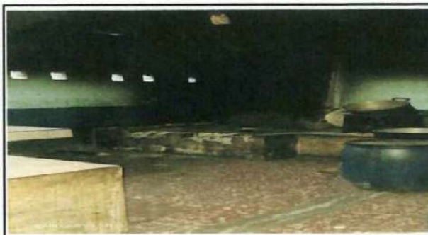
Foto 16: Rehabilitación de cocina del centro educativo (ampliación y elevación de altura)
