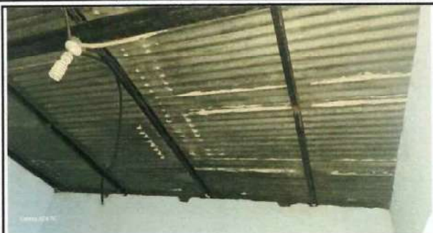
Foto 1: Sustitución de lámina por lámina troquelada, Aula 1
