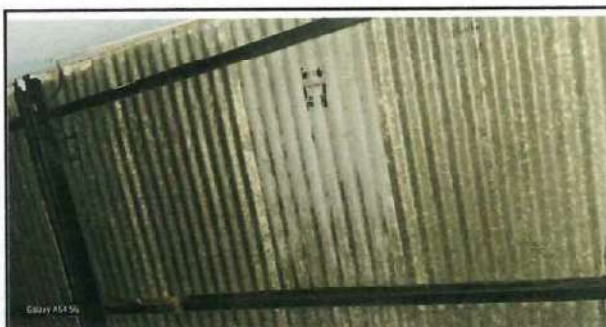
Foto 3: Sustitución de lámina por lámina troquelada, Aula 3
