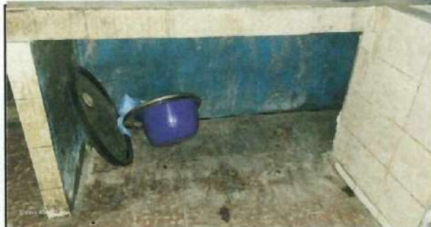
Foto 18: Rehabilitación y ampliación de gabinetes del área de cocina del centro educativo
