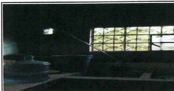
Foto 11: Reparación y ampliación de la red de agua potable del área de la cocina
