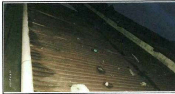
Foto 6: Sustitución de lámina por lámina troquelada, Dirección del centro educativo
