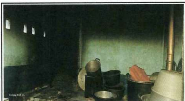
Foto 15: Rehabilitación de cocina del centro educativo (ampliación y elevación de altura)
