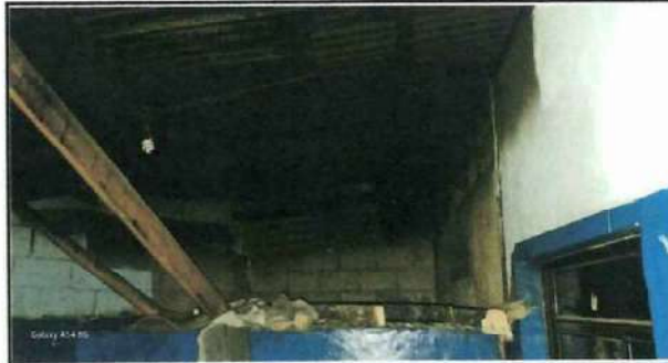
Foto 8: Sustrución de lámina por lámina troquelada, área de tanque de agua
