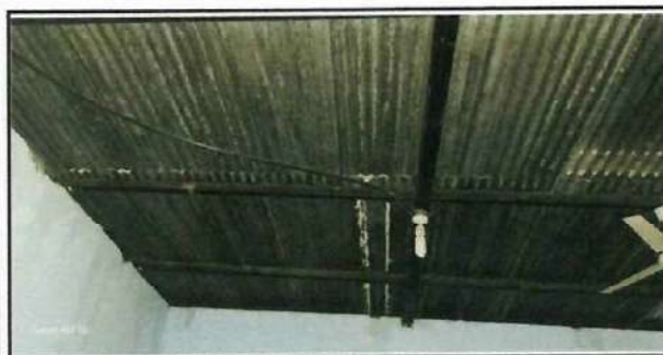
Foto 5: Sustitución de lámina por lámina troquelada, Aula 5
