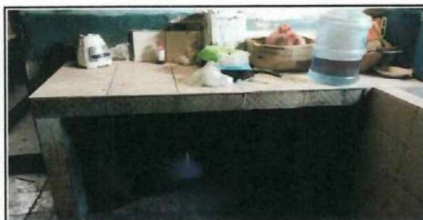
Foto 17: Rehabilitación y ampliación de gabinetes del área de cocina del centro educativo
