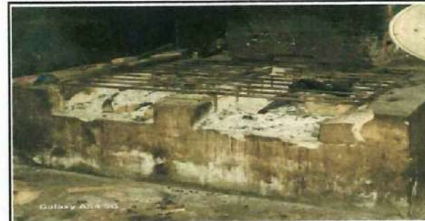
Foto 12: Mantenimiento a estufa rural, ampliación de estufa rural y colocación de extractor de humo
