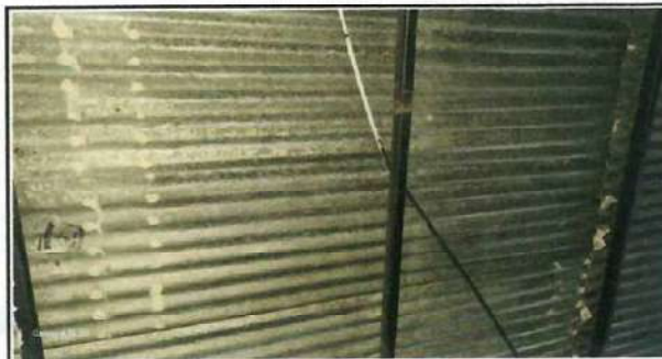
Foto 4: Sustitución de lámina por lámina troquelada, Aula 4
