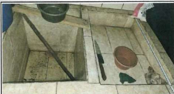
Foto 13: Sustrucción de pila de cemento de un lavadero, por una pila de cemento de dos lavaderos
